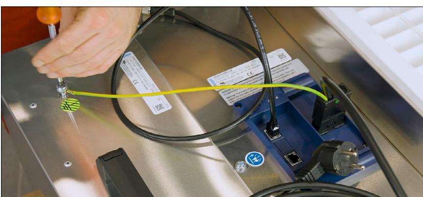
Das Erdungskabel der Stromleitung **2** muss fest mit der Erdungsschraube der FFU verbunden werden
