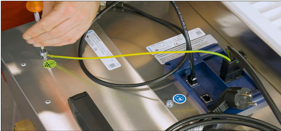
Anschlussbox der FFU mit Erdung!
