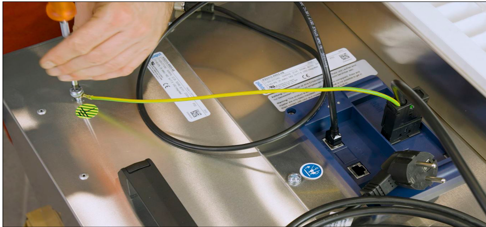
Anschlussbox der FFU mit Erdung!
